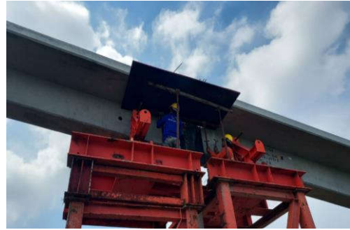
งานเข้าแบบ Ramp Pedestrian Bridge กม.173+005
