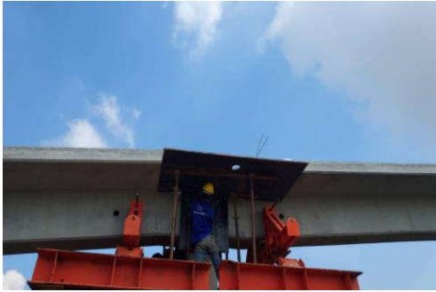
งานเข้าแบบ Ramp Pedestrian Bridge กม.173+005
