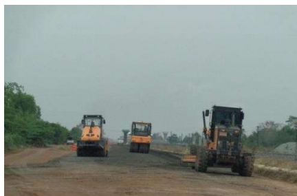
งานบดอัดชั้นดินเพื่อก่อสร้างทางรถไฟ
