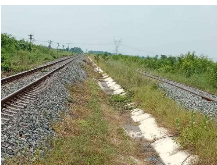
ระบบระบายน้ำทางวิ่งรถไฟระดับดินดิน
